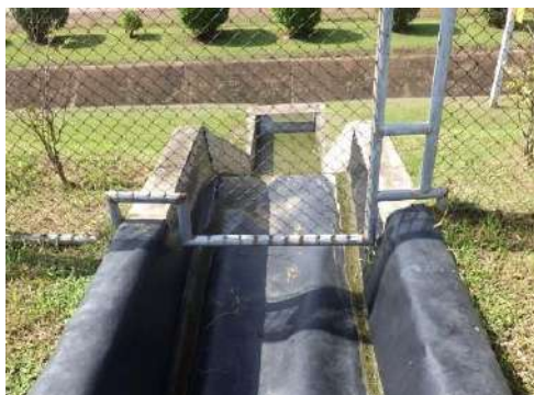
จุดระบายน้ำฝนออกจากบ่อบั่ก หรือ บ่อบรรณน้ำฝนของสถานีผลิตก๊าซ (SW63)
